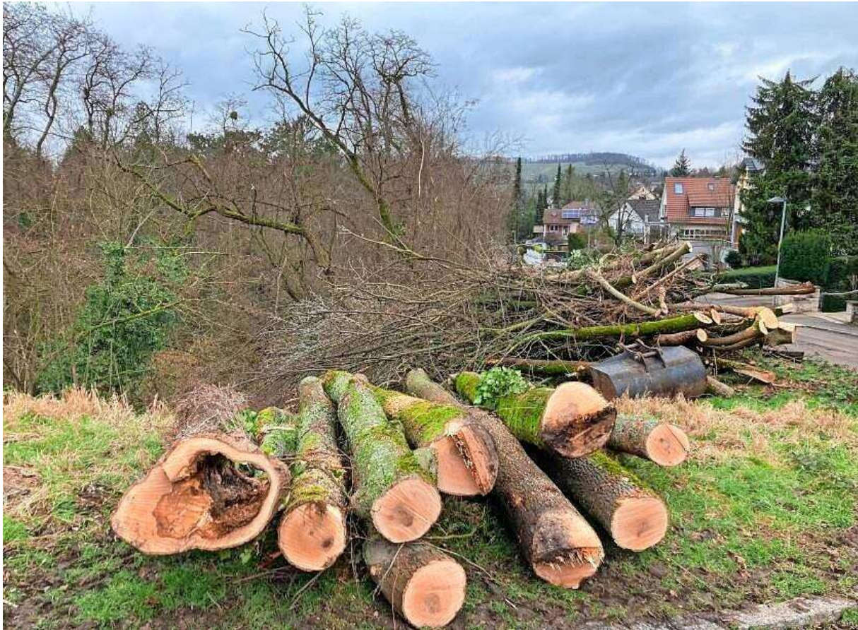
Ordentlich gestapelt: So sieht am Hang über dem Nordportal des Lerchenbergtunnels aus. Foto: Gajer, Simon
