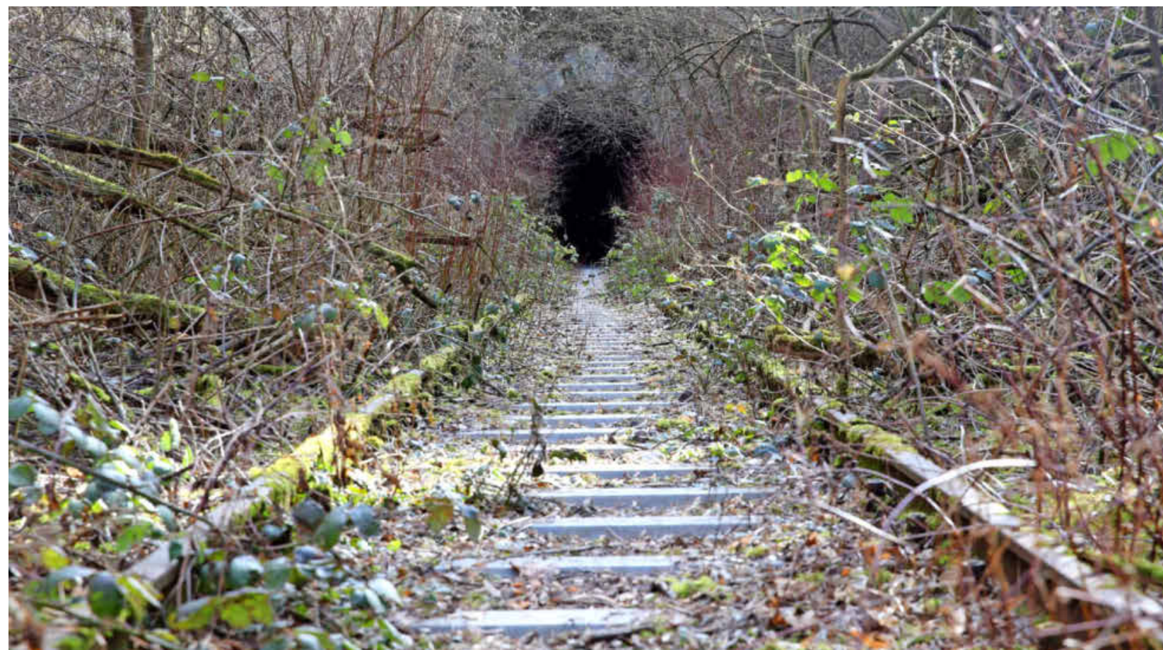
Der 1910/11 gebaute und schon vor Jahren stillgelegte Lerchenbergtunnel ist 400 Meter lang. Ob er für einen Rad- und Fußweg taugt, wird weiter untersucht.
