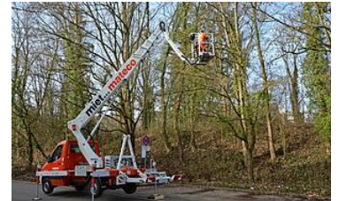
Arbeiter beginnen mit der Ausdünnung der Gehölze am Lerchenbergtunnel. Anwohner sind besorgt – und auch ein Verein hat ein Wörtchen mitzureden.
