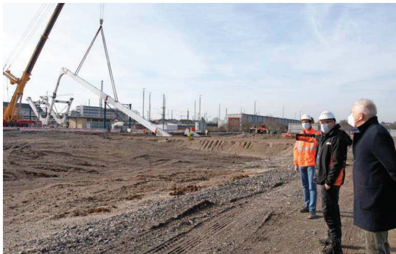
Mit großem Interesse verfolgten Ortwin Sätzler (l.), Projektleiter BUGA-Brücke beim Amt für Straßenwesen, Architekt Roland Bogenrieder und OB Harry Mergel den Baufortschritt. Foto: Kimmerle
