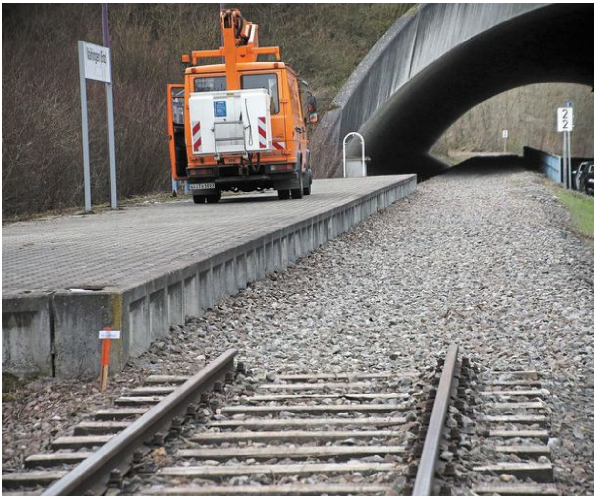
Ein Bahnsteig ohne Schienen: Bei Kleinglattbach wird das Ende der Bahnstrecke deutlich. Künftig sollen dort Radfahrer verkehren. Foto: Alfred Drossel
